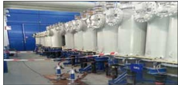
*Medida de sobretensiones entre envoltorios de GIS y pantallas de cables de AT durante las maniobras de interruptores de GIS*
