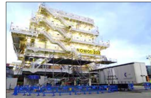
Ensayo de cables de alta tensión que conectan con la plataforma off-shore
